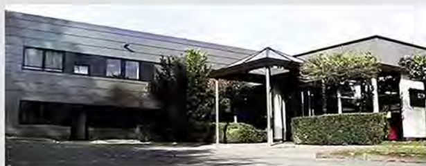
Fabrikgebäude heute / Factory today
